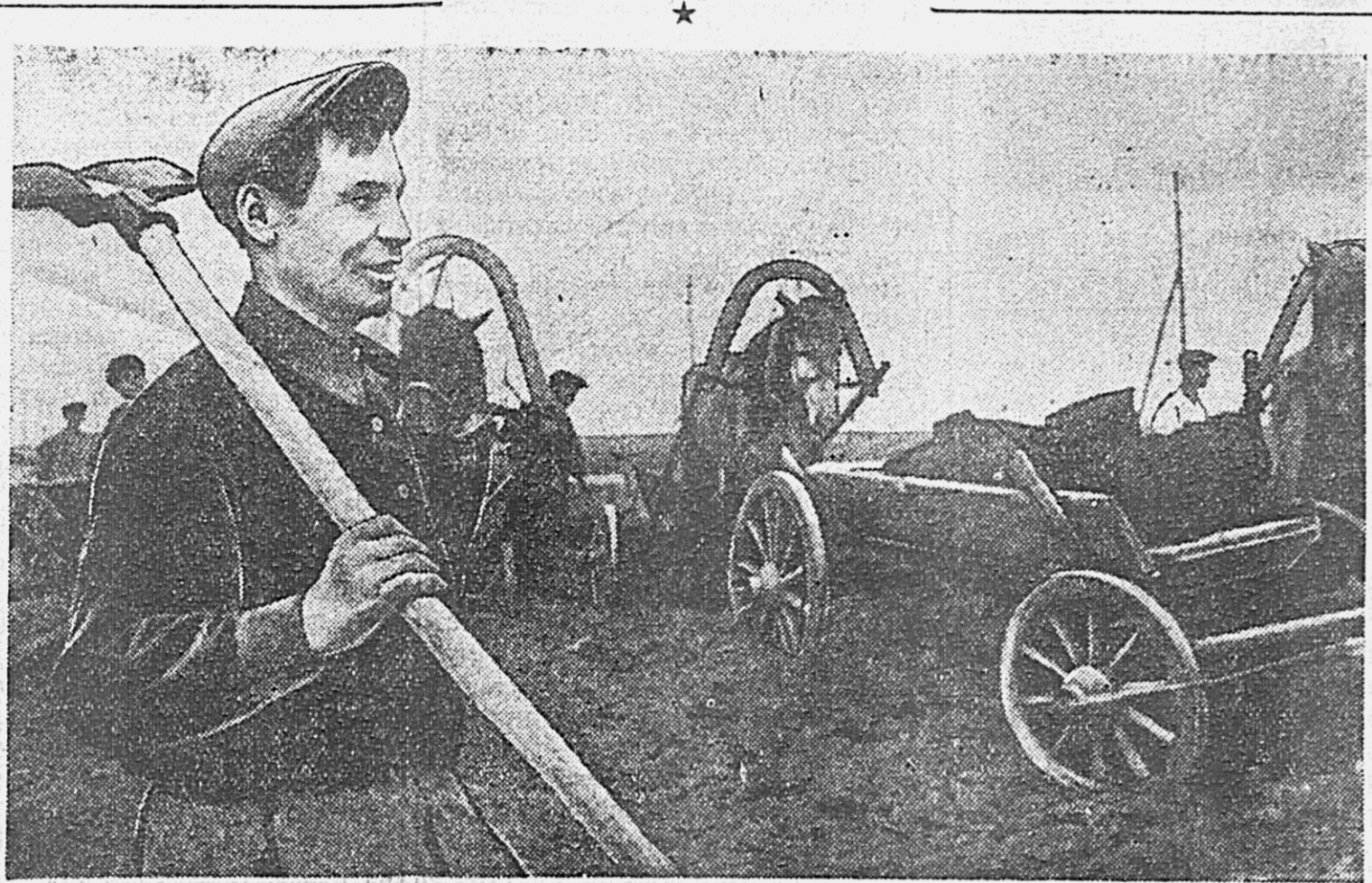
Бригада И. И. Потапова (сельхозартель «Дальневосточный колхозник»), работающая на строительстве колхозных дорог, выполняет задание на 300 процентов. На снимке: бригадир И. И. Потапов на участке. Фото В. Байдалова. (КрайТАСС).
