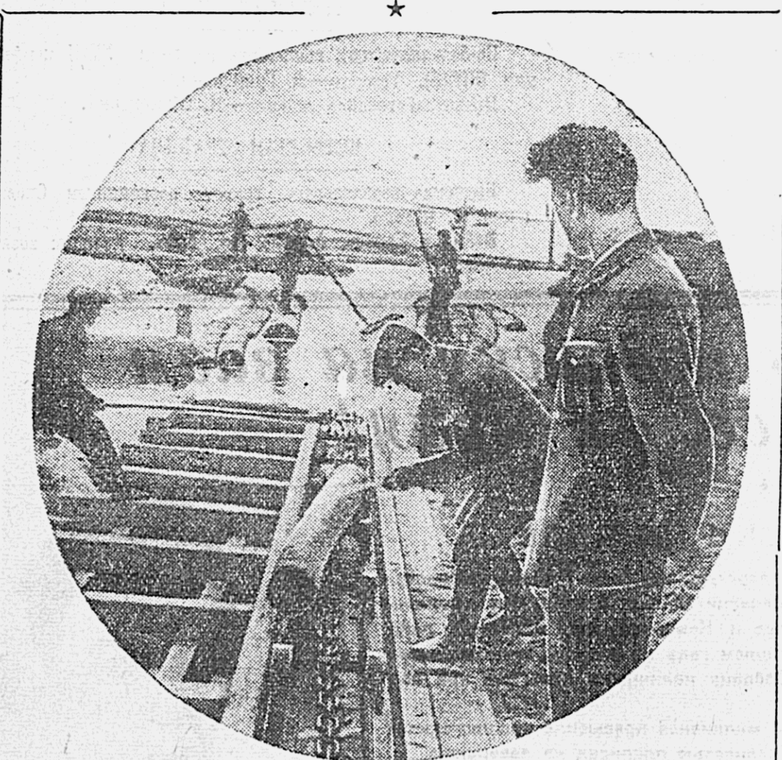
На хабаровском лесозаводе № 9 вступили в эксплуатацию биржевая бревноватса. Благодаря этому выкат леса на воды увеличился в четыре раза. На снимке: бревноватса за работой. Фото В. Байдалова. (КРАЙТАСС).
