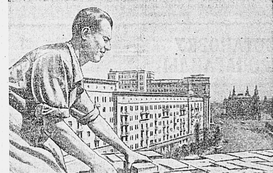
525 больших благоустроенных жилых домов получат москвичи в нынешнем году. Возводятся красивые здания на многих улицах магистральной столицы...
