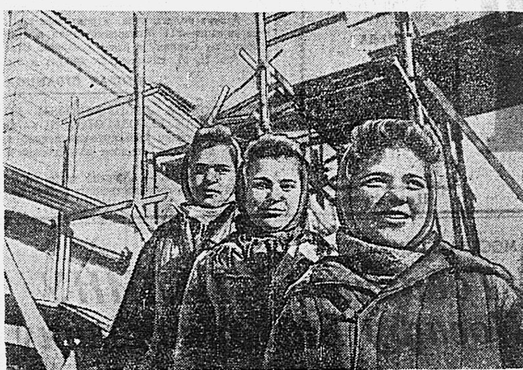
Бригада штукатуров, которой руководит Мария Малышко, занимает одно из первых мест среди молодежных бригад Комсомольска. Работая на строительстве жилых домов, девушки выполняют около двух норм ежедневно. На снимке: комсомолки-штукатеры (справа налево) Мария МАЛЫШКО, Мария ЛЫСАК и Екатерина НАУМЕНКО.
