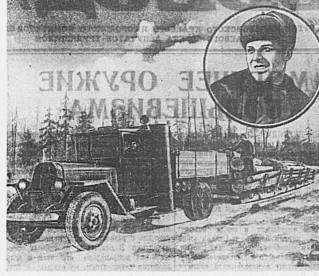
Поездная вывозка леса по автолесьной дороге на лесопункте «Кутузовка» Хорского леспрохоза. В овале стажировщик шофер И. И. Щур.
