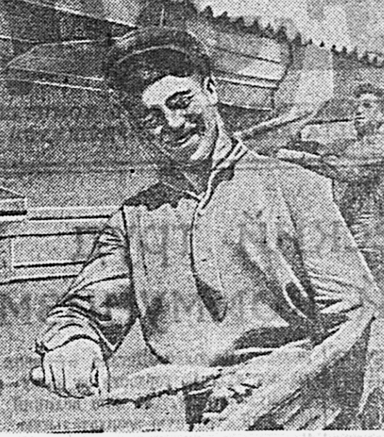
Хабаровская школа ФЗО № 3 строителей готовит кадры штукатуров, плотников, каменщиков для построек нашего края. Учащиеся проходят производственную практику на строительных школах и жилых домах в Сталинском районе. На снимке: отличник учебной штукатурки Яков ЧЕРНЕНКО за отделкой фасада дома. Фото Н. Суворова.
