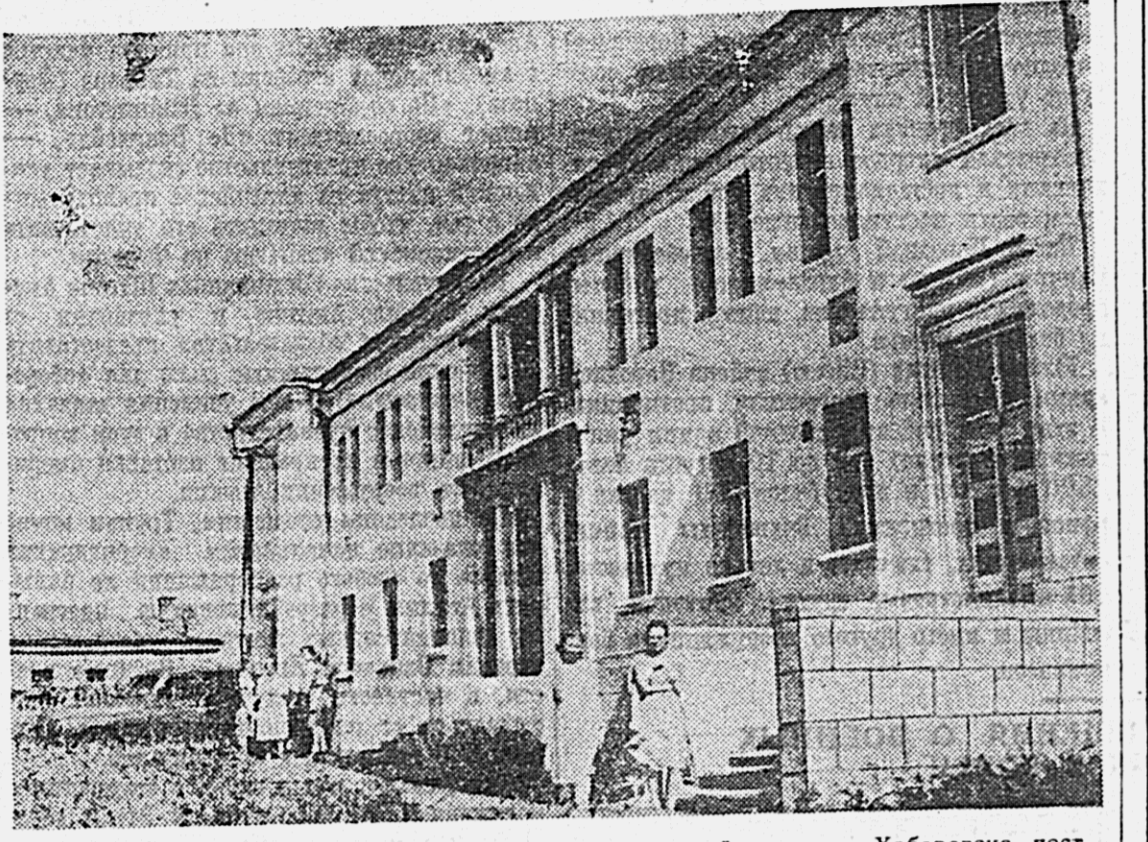
На снимке: здание родильного дома в Сталинском районе города Хабаровска, построенное в этом году. Фото Г. Ложкина.
