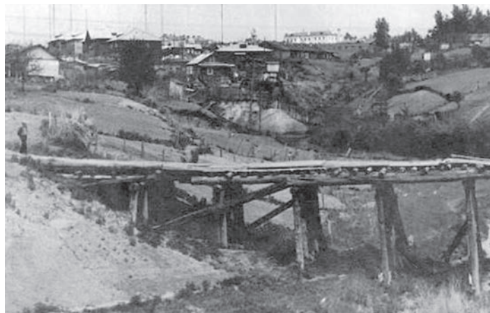
Мост через речку Плюснинку по улице Сапёрной, 1952 год. Фотография публикуется впервые.
