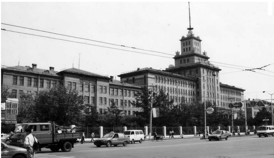
Новый корпус Харбинского политехнического института, 1950-е годы. (Фото автора.)
