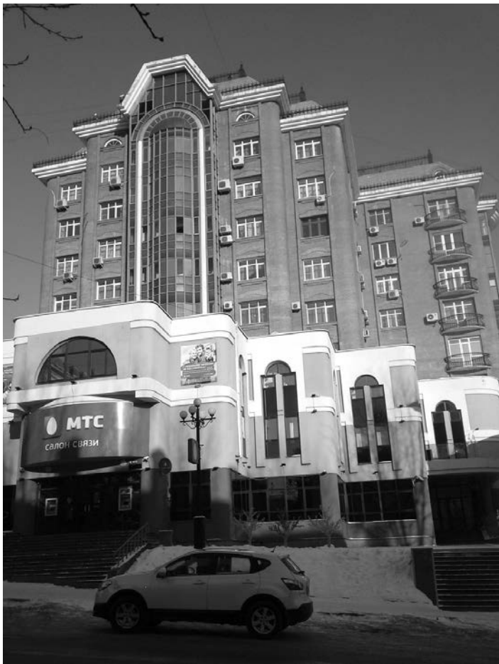
Пример «нового кирпичного стиля». Хабаровск, ул. Пушкина, 42.
