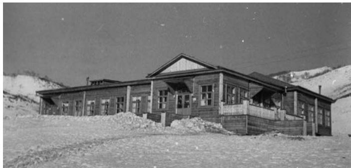
Строительство больницы в посёлке Индустриальном, 1936 год.
