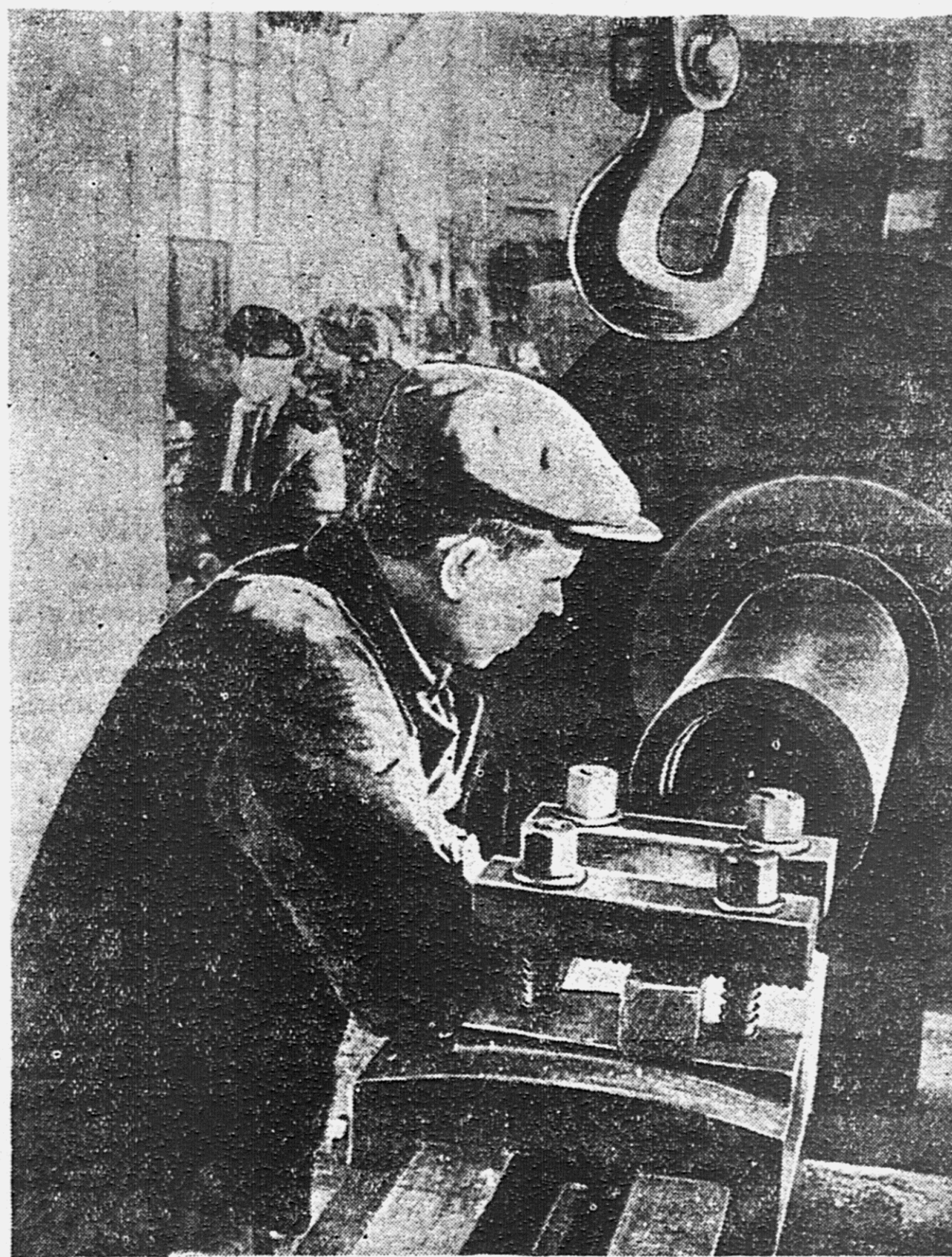
Стахановец Хабаровского судоремонтного завода, токарь П. И. Ершов, систематически выполняет нормы на 250—300 процентов. На снимке: тов. Ершов за проточкой втулки.
