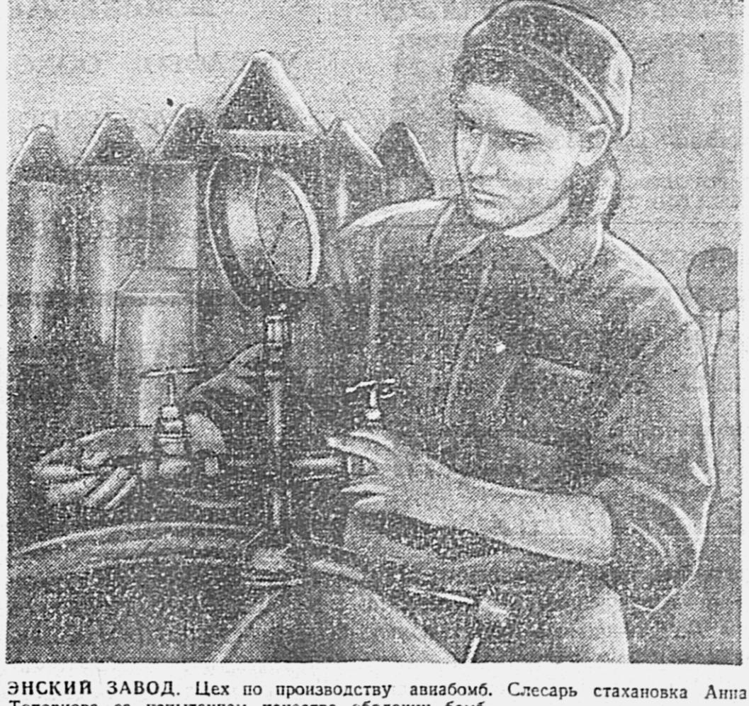
ЭНСКИЙ ЗАВОД. Цех по производству авиабомб. Слесарь стахановка Анна Топоркова за испытанием качества оболочки бомбы.
